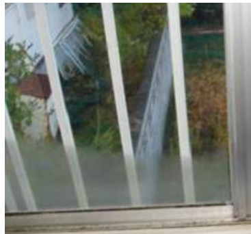
<施工後> 朝方 結露の改善
